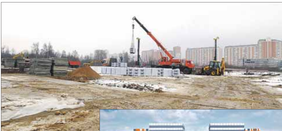
На стройплощадке полным ходом идут работы
